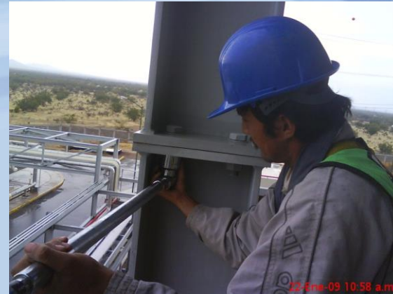
Aplicación de torque a unión de columnas.
