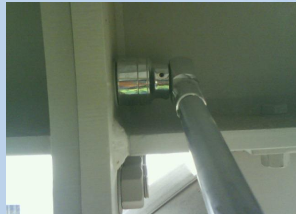
Aplicación de torque a unión de traves.
