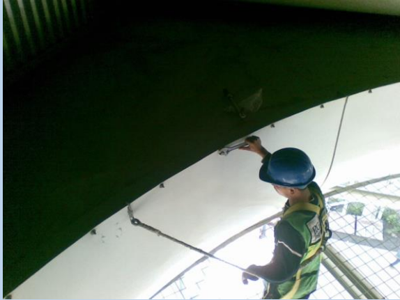
Ajuste de tornillería en alerón de ventilador.
