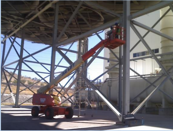
Aplicación de torque entre columna y PTR.
