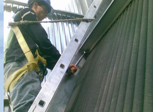
Ajuste de tornillería en exterior de filtros.
