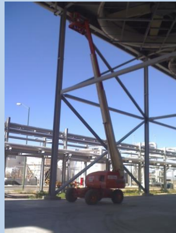
Aplicación de torque en traves.
