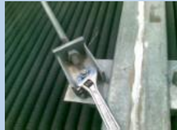
Ajuste de tornillería en tensores exteriores.
