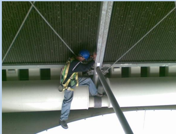
Ajuste de tornillería en interior de filtros.
